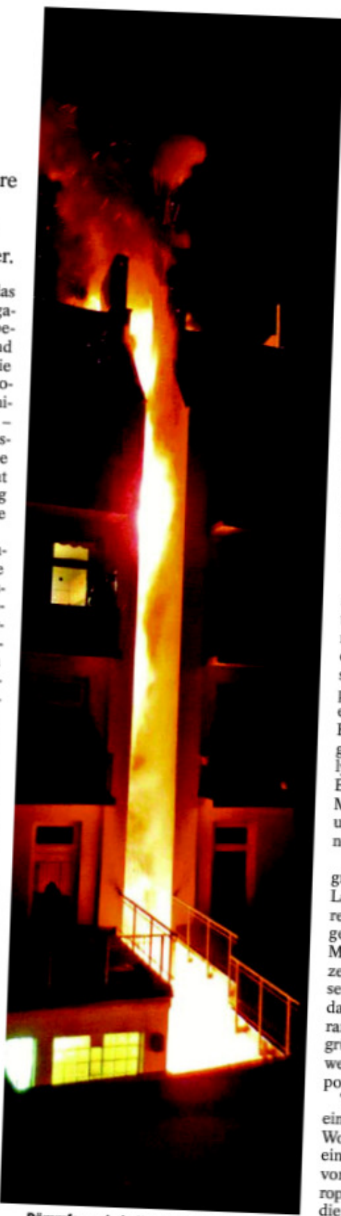
Dämmfassade in Hamburg in Flammen „Mindestabstand für Autos und Mülltonnen“
