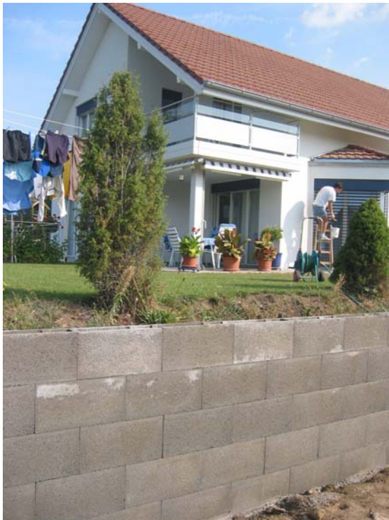
Bild 1: SCHALIT Schalungsstein als Hangsicherung
