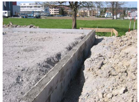
Bild 2: SCHALIT Schalungsstein als Frostriegel
