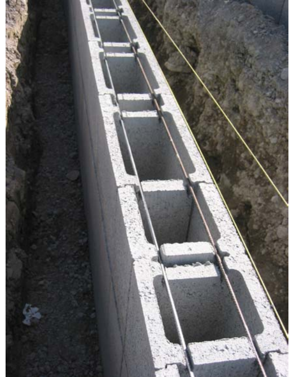
Bild 19: Vorgesehene Aussparungen für Bewehrung bei SCHALIT Schalungsstein
