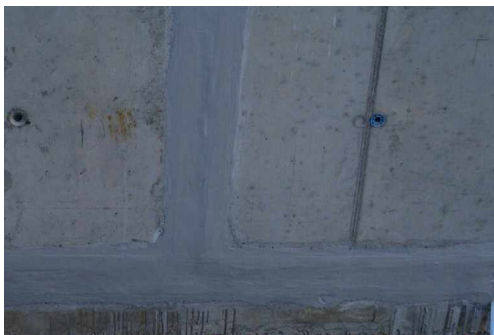
Fuge mit Kombiflexband abgedichtet
