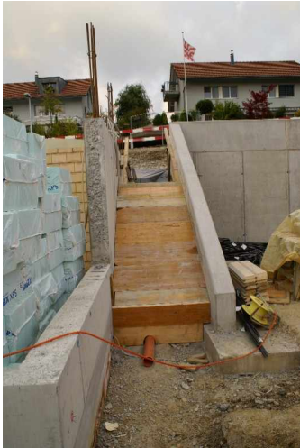
Aussentreppe mit Sickerleitung
