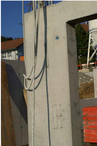
Anschlüsse im Beton
