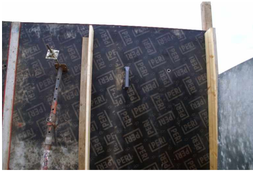
Einlage vom Elektriker
