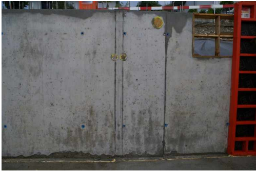
Erdsonden- und Fortluftdurchgang
