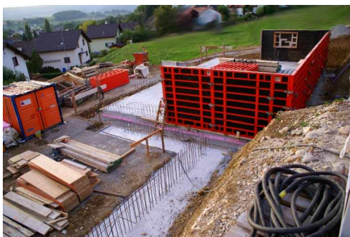
Erste Mauern stehen
