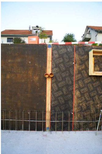
Aussparung für Erdsondenzugang
