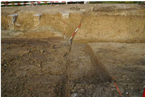
Streifenfundament unserer Aussentreppe
