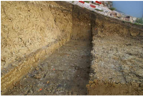
Streifenfundament unserer Gartenmauer
