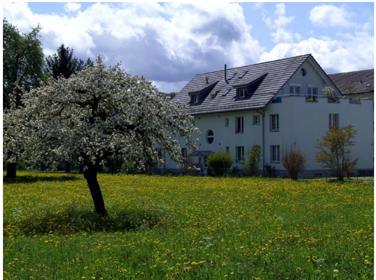
Hausansicht von der Strasse gesehen
