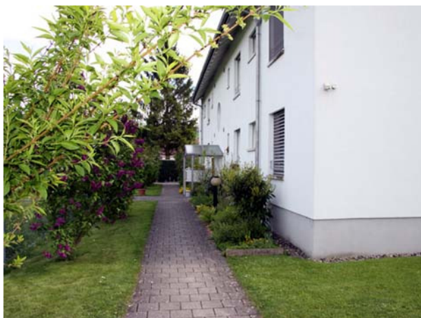
Erschliessungsweg mit Verbundsteinen
