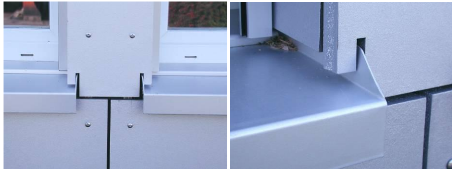
Beispiel eines Fensterbankanschlusses
