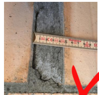
Falsch Stossfuge > 15 mm
