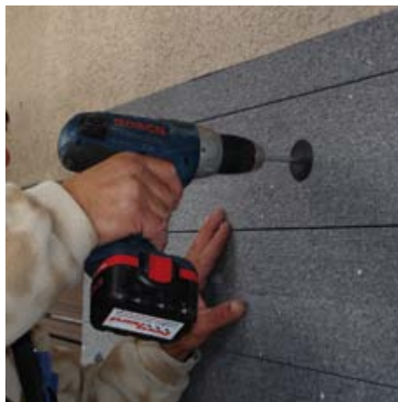
Montage swissporLAMBDA Vento auf verputzte Aussenwärmedämmung mit Schraubdämmstoffhalter (z.B. Rogger Fasteners AG)
