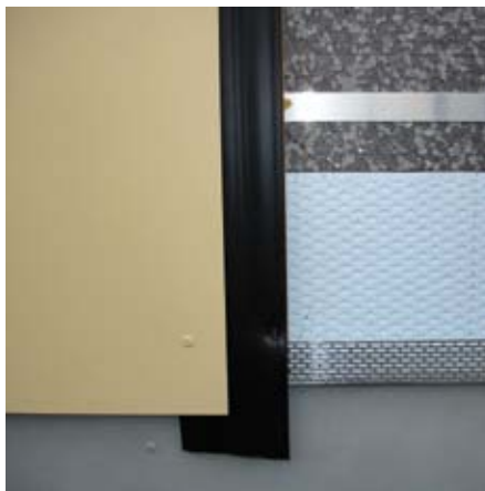
Lüftungsgitterblech im Sockelbereich
