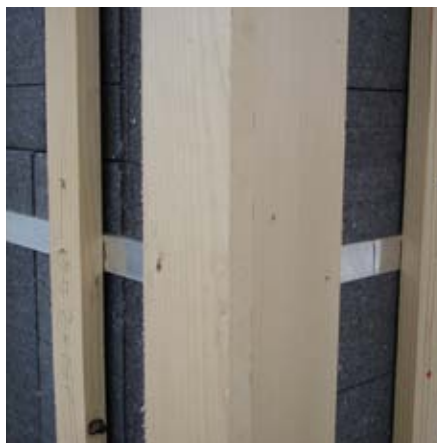
Montage swissporLAMBDA Vento auf verputzte Aussenwärmedämmung mit Schraubdämmstoffhalter (z.B. Rogger Fasteners AG)
