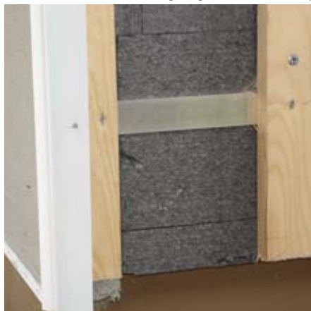
Aussenecke mit Übergang an eine Kompaktfassade
