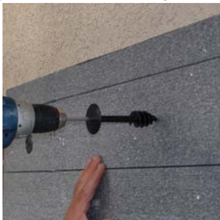
Montage swissporLAMBDA Vento auf verputzte Aussenwärmedämmung mit Schraubdämmstoffhalter (z.B. Rogger Fasteners AG)
