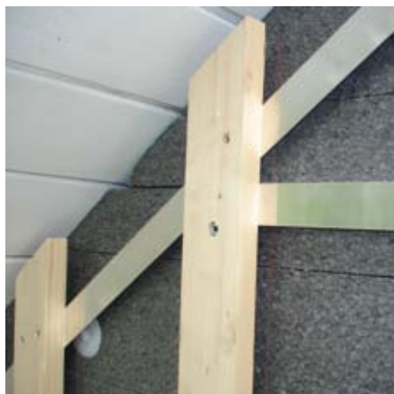
Anschnitt an eine Dachuntersicht
