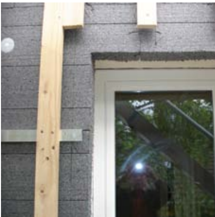
Vorbereitet für die Zargenmontage
