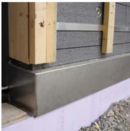
Verlegen von swissporLAMBDA Vento im Sockelbereich
