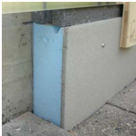
Verlegen von swissporLAMBDA Vento im Sockelbereich
