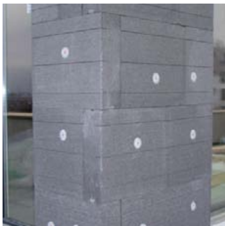
Montage swissporLAMBDA Vento auf verputzte Aussenwärmedämmung mit Schraubdämmstoffhalter (z.B. Rogger Fasteners AG)
